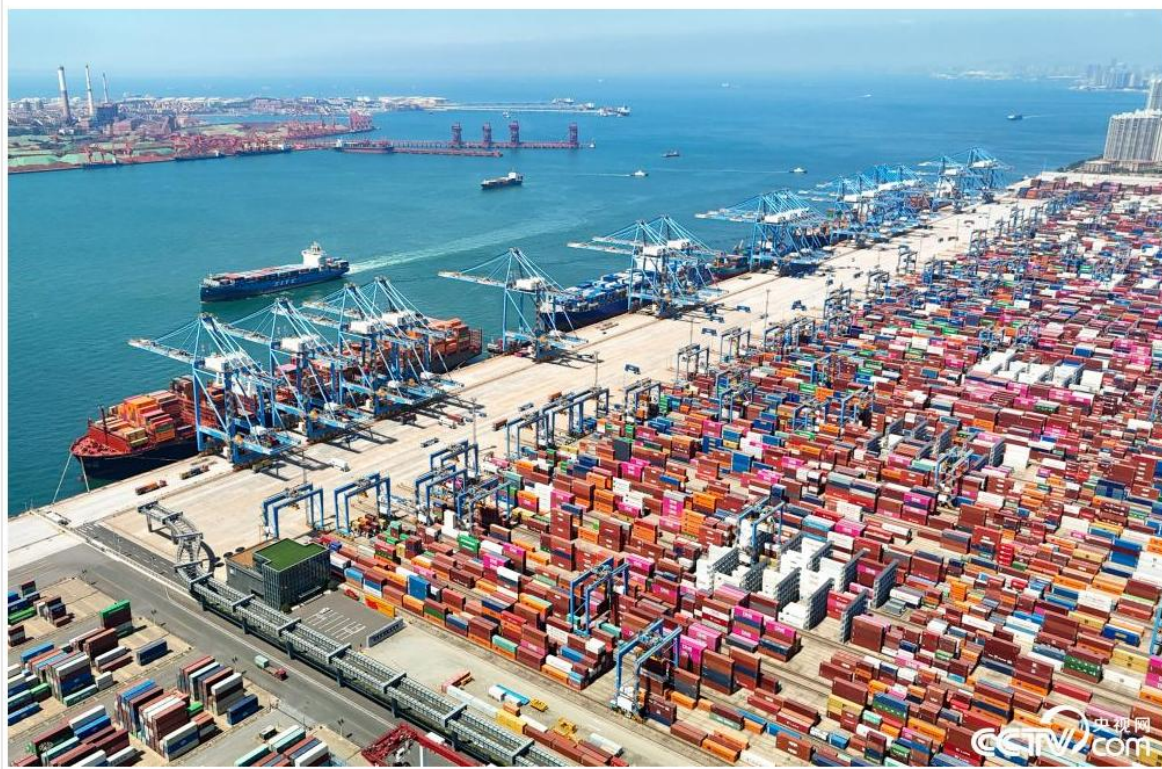
图9 青岛港码头全景
