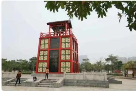
水运仪象台是北宋苏颂在1088年制造出来的，它长7m，宽7m，高12m，看起来就像一座城楼，不过别看水运仪象台看起来像城楼，其实里面暗藏玄机，集观星和报时于一体。水运仪象台主要分为上中下三层，上层是观星台，上面安装有一个由四根龙柱支撑
